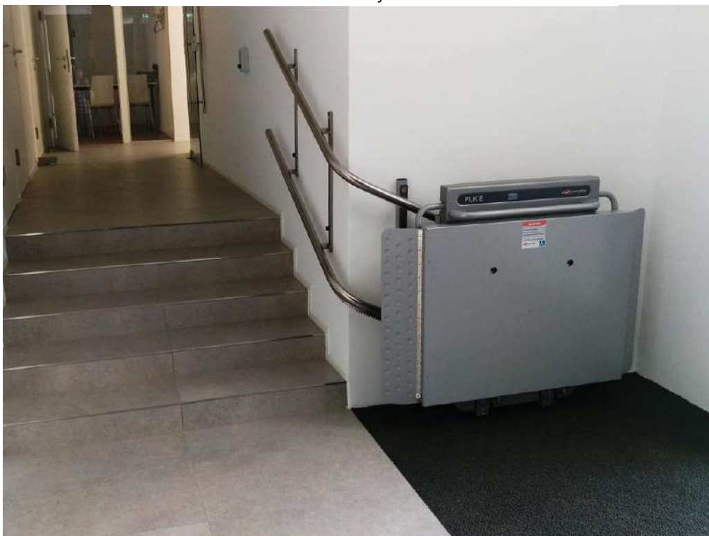
Przystanek dolny - platforma złożona, montaż szyny jezdnej do ściany.
