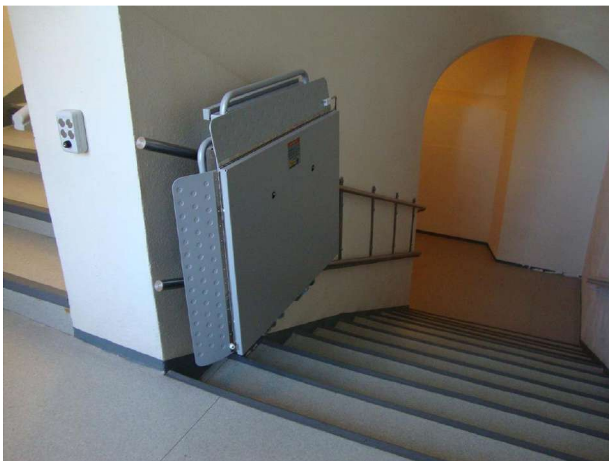
Przystanek górny - platforma złożona, montaż szyny jezdnej do ściany.
