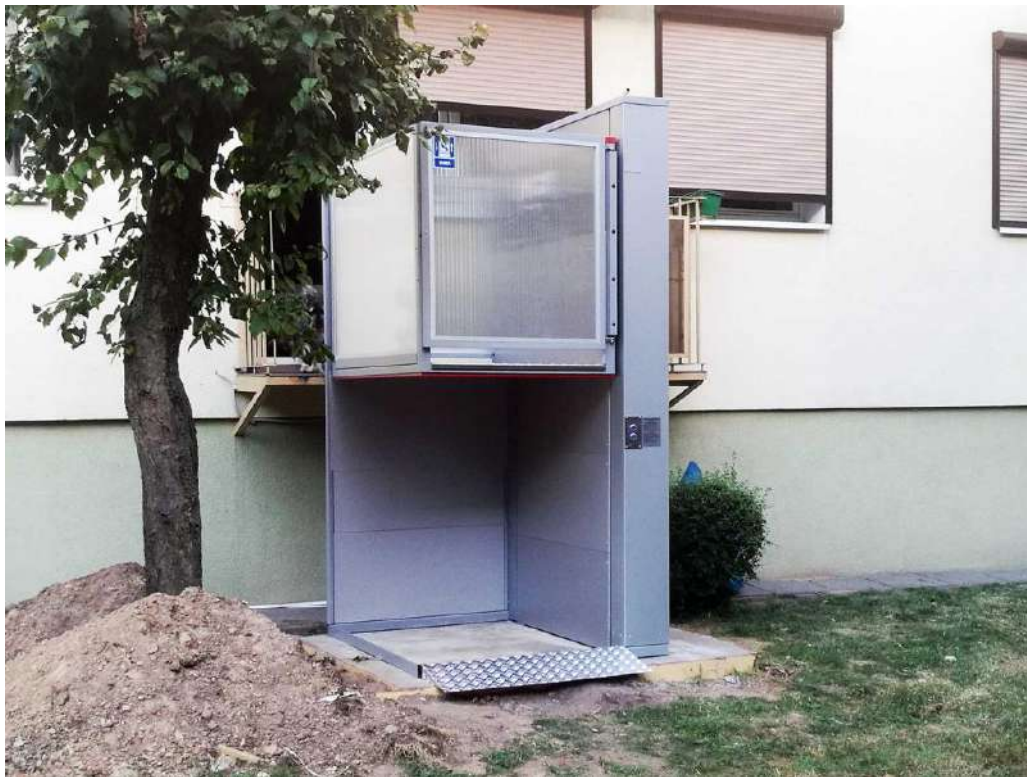
Podnośnik na górnym przystanku w wersji przelotowej.
